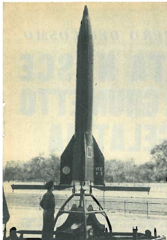
Al «Salone del Progresso» di Parigi è stato esposto questo razzo a reazione, lungo m. 6, del peso di 1 tonnellata e che può raggiungere la velocità di 5 mila km. all'ora.
